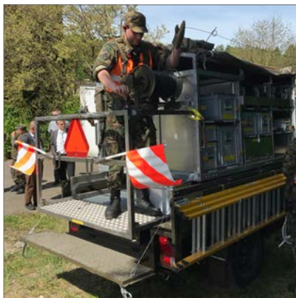
Construction de lignes
